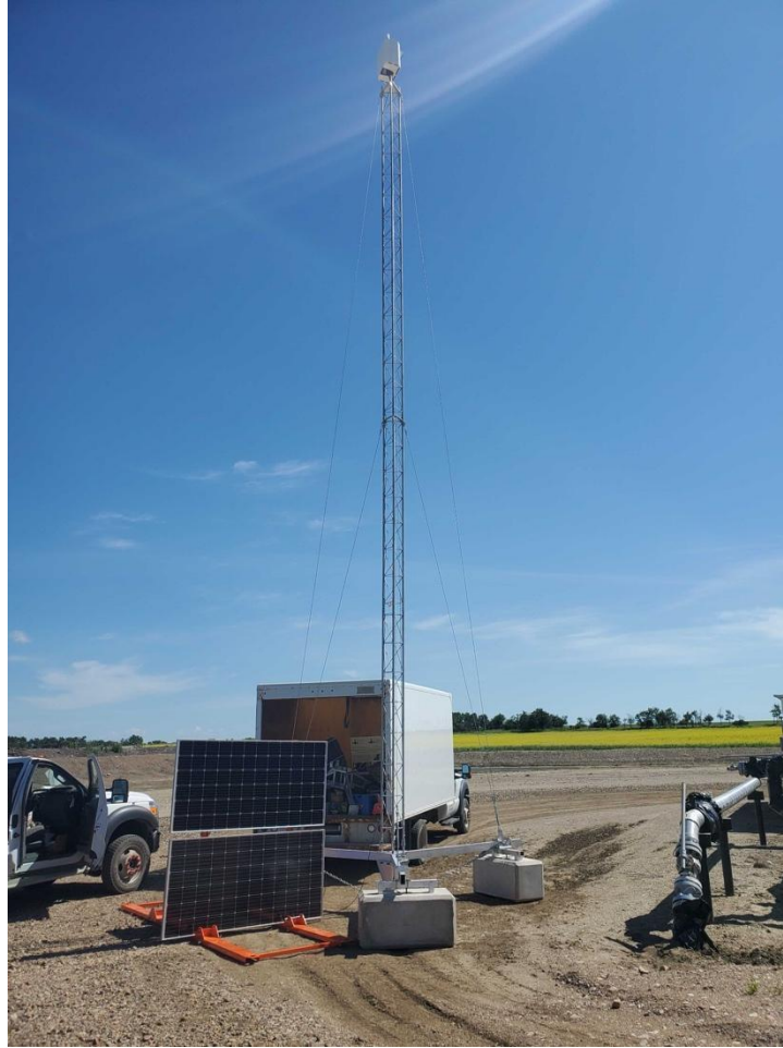
Figure 3-2 Kuva Camera on Kuva Tower with Solar Skid
